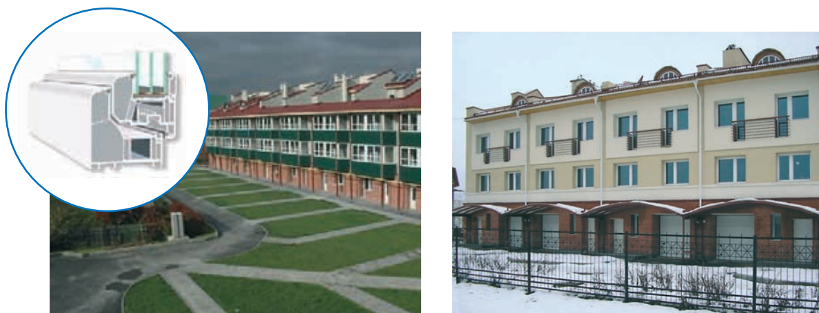
Рис. 4. 1. Экспериментальный жилой комплекс в Куркино, г. Москва. Оконные конструкции изготовлены из профильной системы TOPLINE PLUS.
