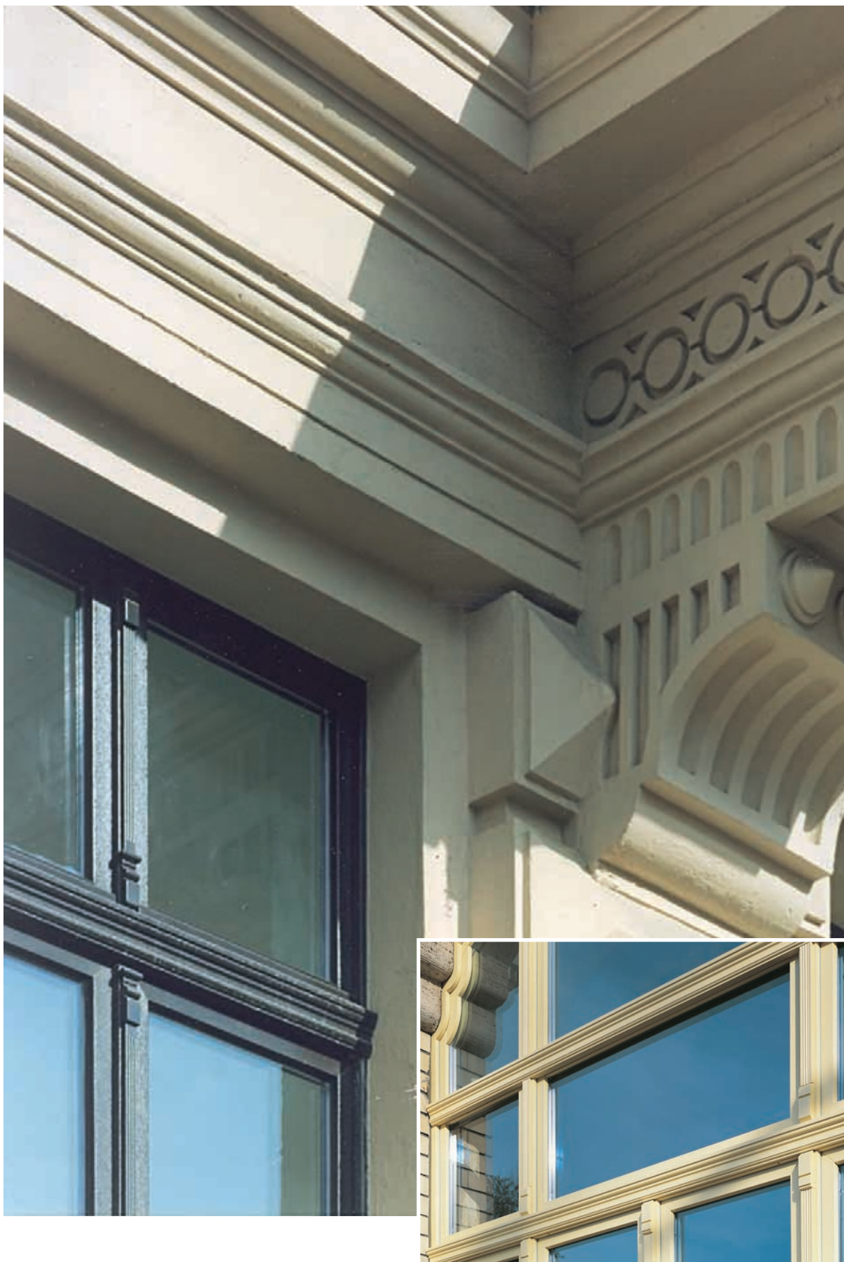
Рис. 3.16. Возможности оконных систем из ПВХ при реконструкции
